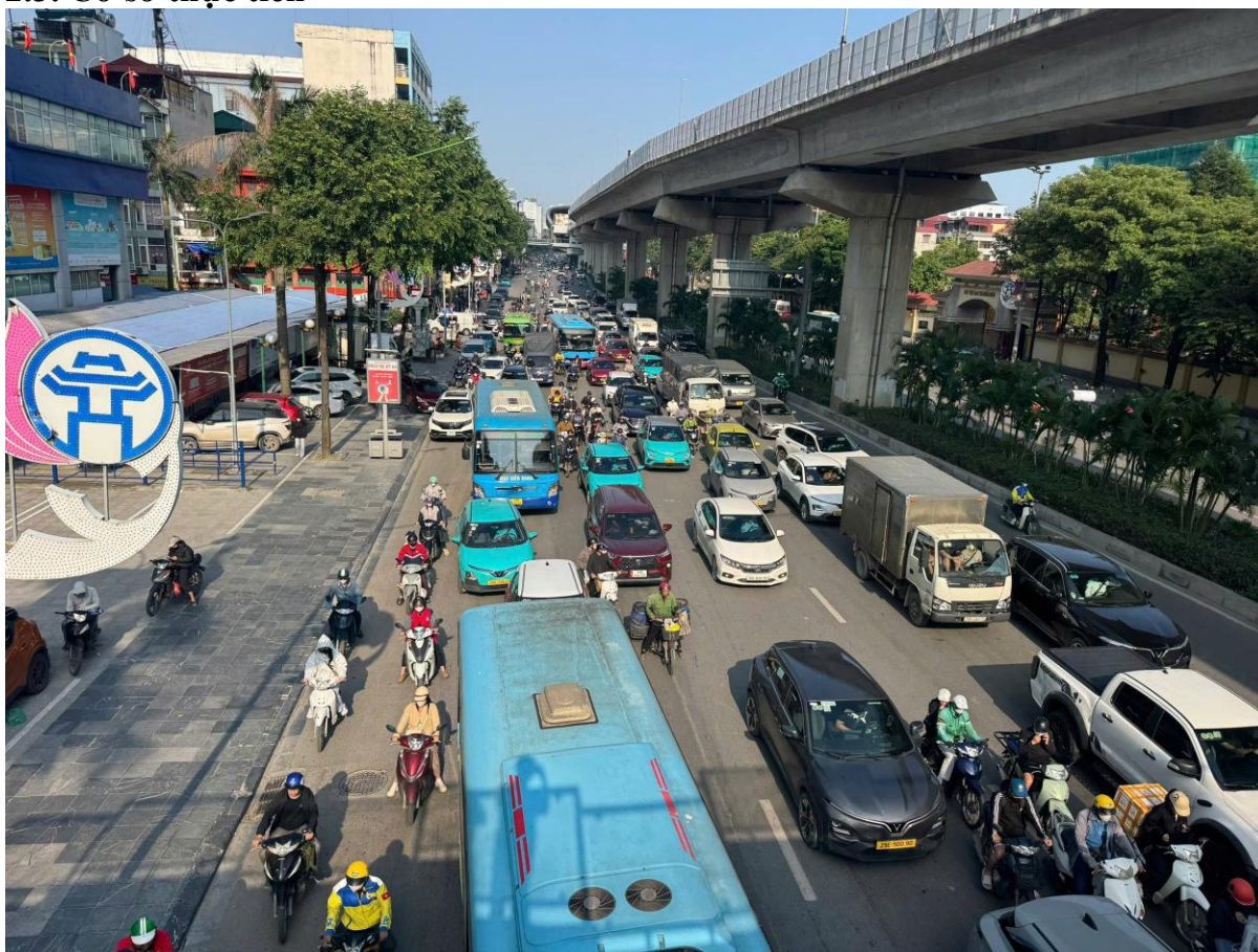
Hình 2.2. Hiện trạng giao thông dọc tuyến Metro 2A tại Hà Nội
