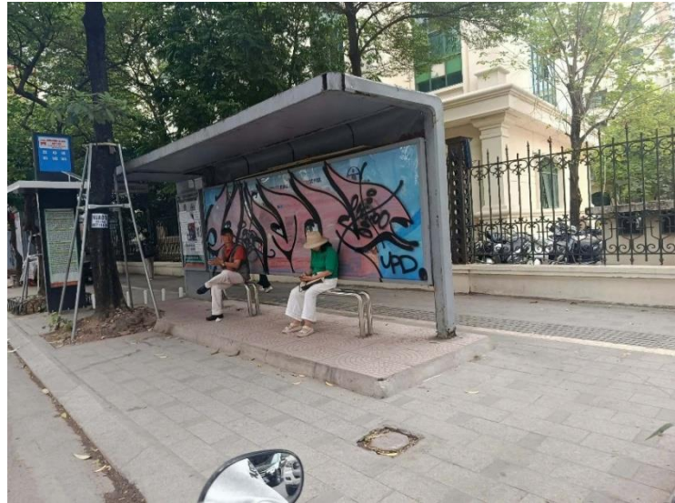
Hình 2.12. Hệ thống mái che tại các điểm dừng xe buýt.
