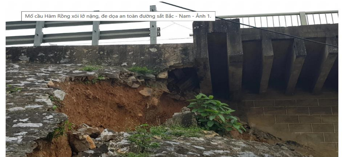
Mố cầu Hàm Rồng (TP Thanh Hóa) bị xói lở, sụt lún nghiêm trọng - Ảnh: HÀ ĐỒNG
