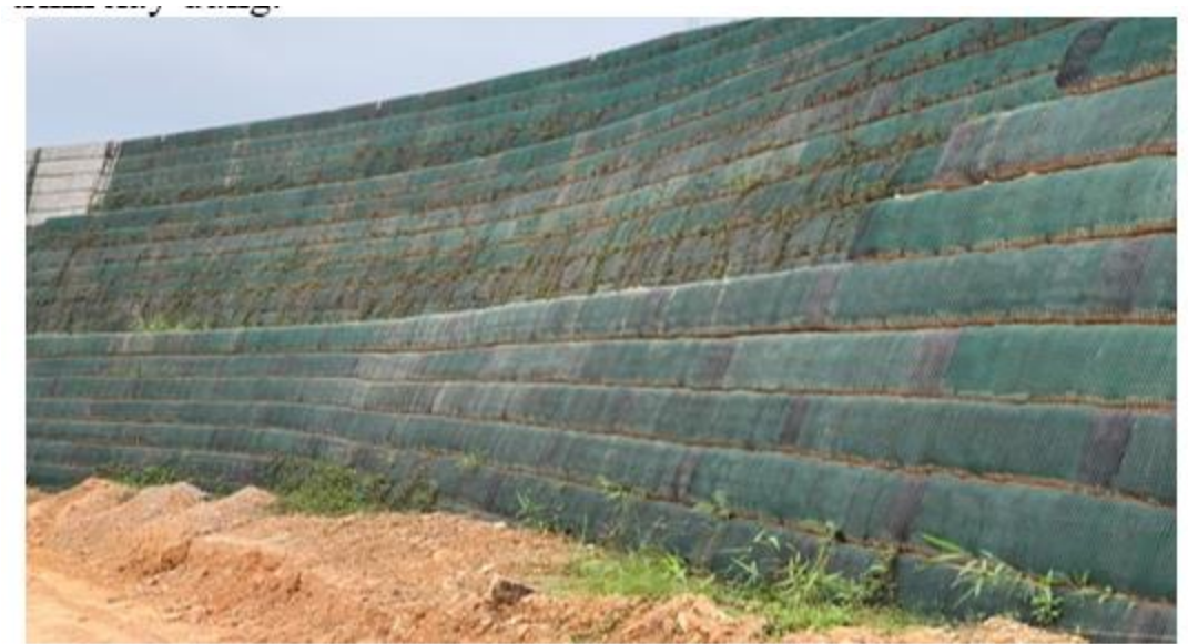
Hình 4. 22. Mái dốc được gia cố bằng tường chắn đất có cốt
