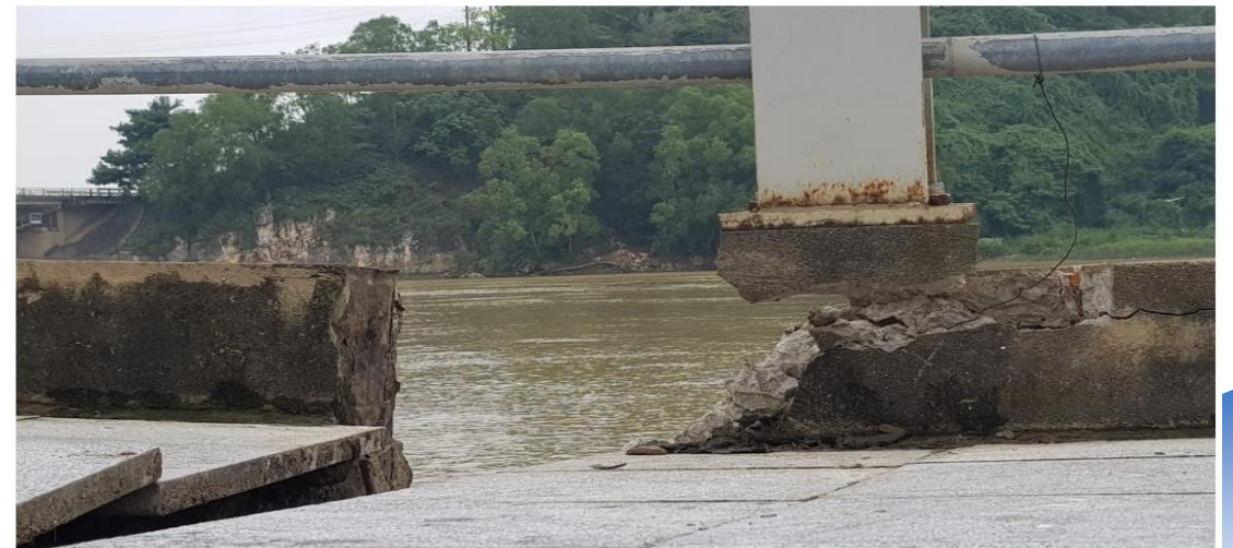
Mố cầu Hàm Rồng (TP Thanh Hóa) bị xói lở, sụt lún nghiêm trọng - Ảnh: HÀ ĐỒNG
