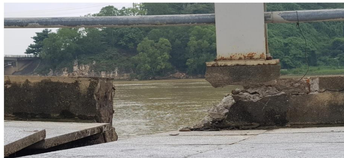
Mố cầu Hàm Rồng (TP Thanh Hóa) bị xói lở, sụt lún nghiêm trọng - Ảnh: HÀ ĐỒNG
