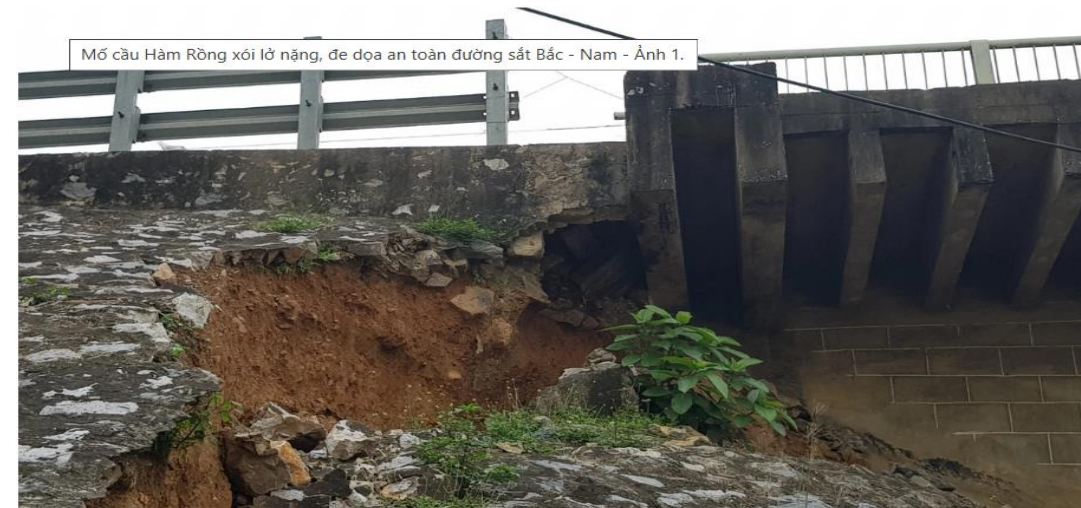
Mố cầu Hàm Rồng (TP Thanh Hóa) bị xói lở, sụt lún nghiêm trọng - Ảnh: HÀ ĐỒNG
