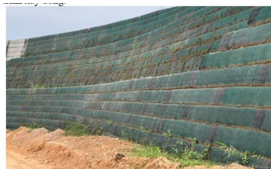
Hình 4. 22. Mái dốc được gia cố bằng tường chắn đất có cốt
