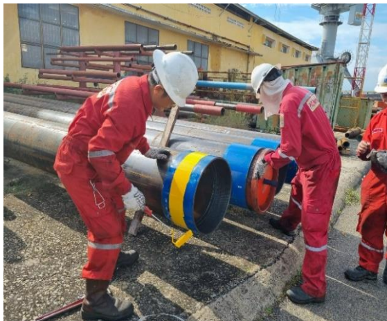
Hình 5. Kết nối sẵn chèo khoan 24" và van ngược vào các đoạn ống tại căn cứ
