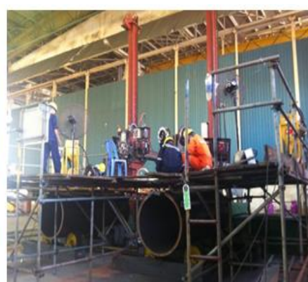
Hình 8. Hàn ngoài bằng trạm hàn 2 mỏ - Tandem
