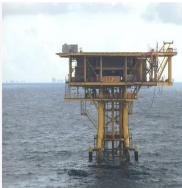
BK-20 tại mỏ Bạch Hổ, xây dựng năm 2019 - Là giàn BKM loại 4 chân, đứng độc lập, có 9 lỗ giếng khoan
