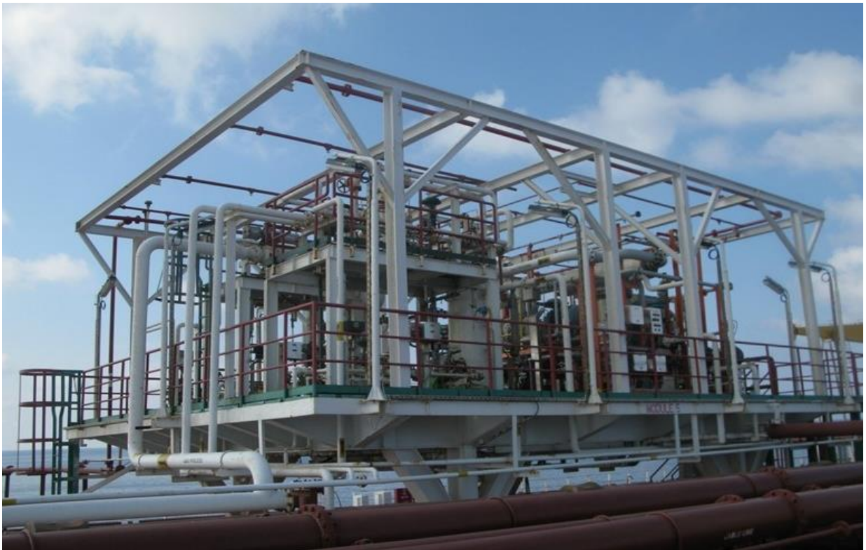
Hình 6. Hệ thống thu gom khí hydrocarbon trên FSO VSP-02
