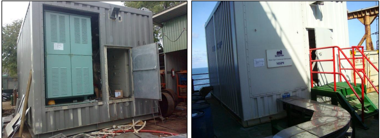
Hình 2. Hình ảnh của một trạm máy biến áp điển hình trong HTCCĐHN
