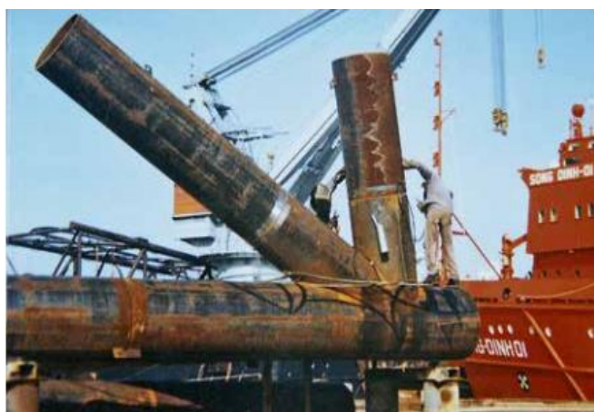
Hình 3. Tổ hợp các cấu kiện chân đế giàn khoan tại bãi chế tạo của Vietsovpetro tại Vũng Tàu
