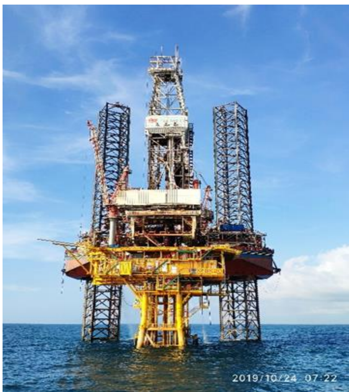
Hình 7. Giàn BK-20, giàn nhẹ loại nhỏ (mini BK) đầu tiên do Vietsovpetro tự thiết kế, chế tạo và lắp đặt
