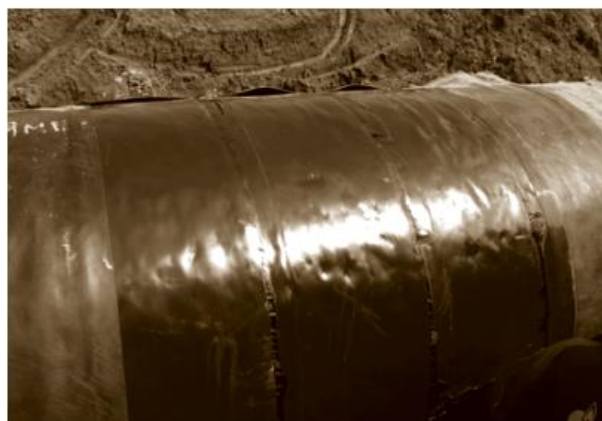
Рис. 4. Внешний вид покрытия на основе нефтеполимера Асмор после шести лет эксплуатации.
