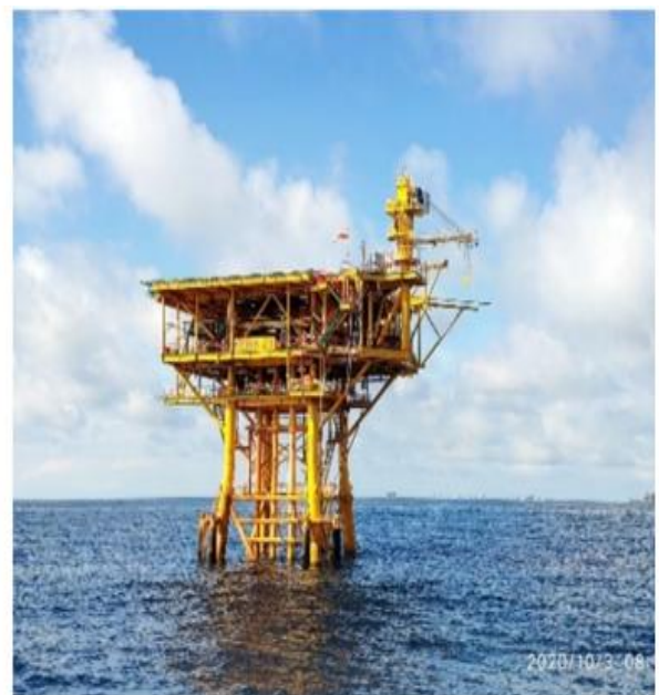
BK-21 tại mỏ Bạch Hổ, xây dựng năm 2020 - Là giàn BKM loại 4 chân, đứng độc lập, có 9 lỗ giếng khoan
