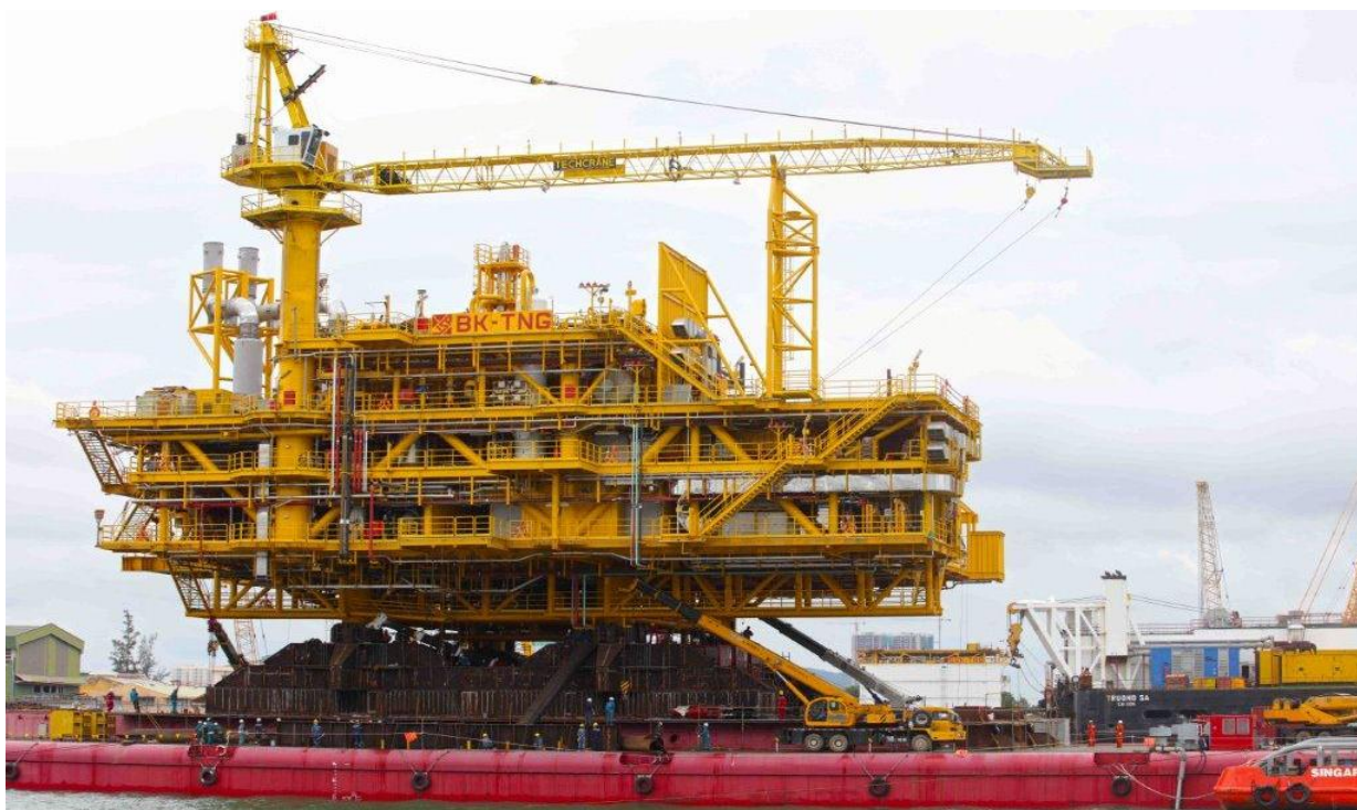
Hình 2. Hạ thủy Khối thượng tầng /Topside giàn BK-TNG
