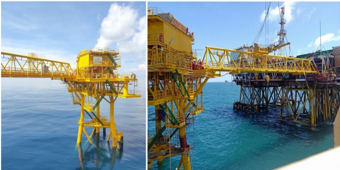
BK-18A tại mỏ Bạch Hổ, xây dựng năm 2021 - Là giàn BKM loại 3 chân, đứng cạnh giàn host platform MSP-9, nối với nhau qua cầu dẫn, có 6 lỗ giếng khoan
