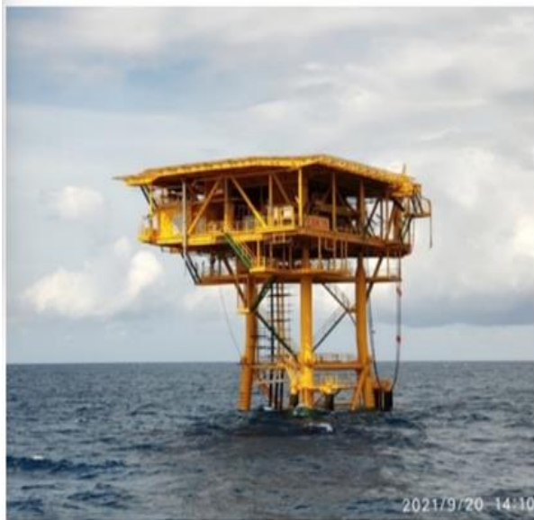
BK-19 tại mỏ Bạch Hổ, xây dựng năm 2021 - Là giàn BKM loại 3 chân, đứng độc lập, có 6 lỗ giếng khoan
