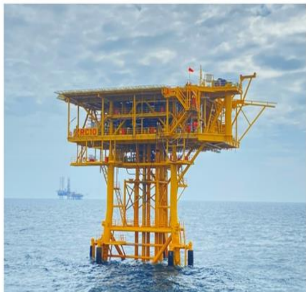
RC-10 tại mỏ Rồng, xây dựng năm 2022 - Là giàn BKM loại 3 chân, đứng độc lập, có 6 lỗ giếng khoan
