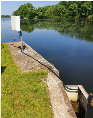
Điểm quan trắc nước mặt, thời gian thực lắp đặt năm 2022 - VIWAT3
