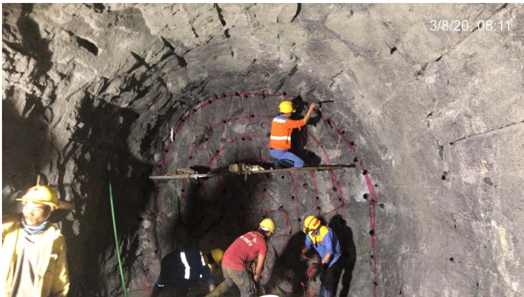
Hình 3.4. Thi công đấu ghép mạng nổ mìn tại dự án
