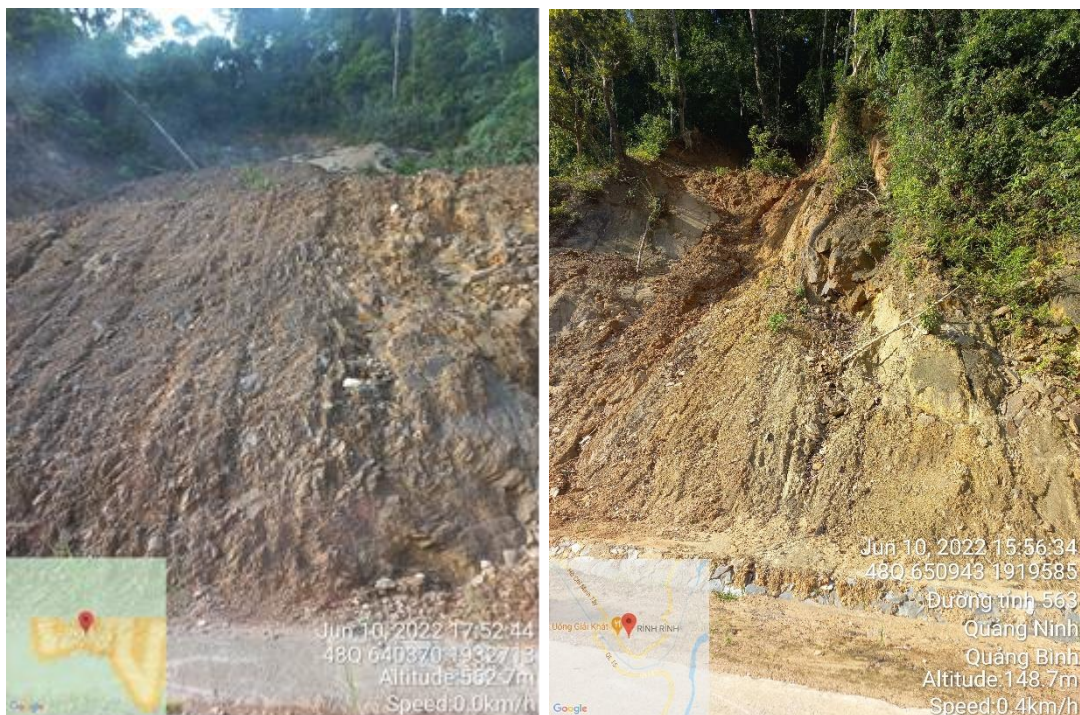
Hình 3. Trượt trên đá phiến sét hệ tầng Long Đại dưới
