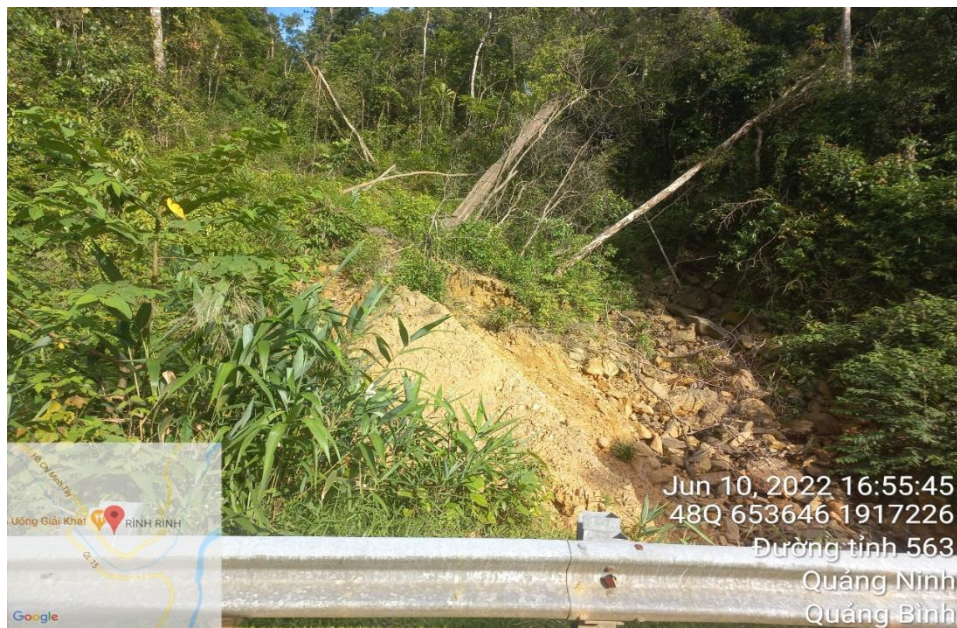
Hình 1. Lũ bùn đá ở khe giữa núi trên sườn taluy dương đường tỉnh ĐT563
