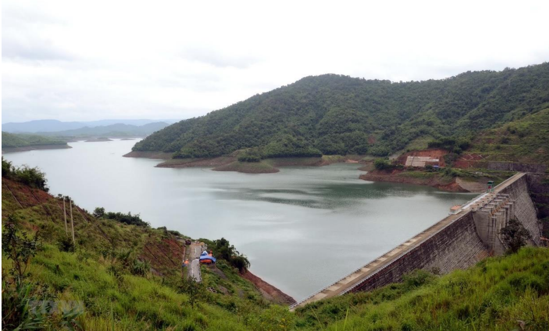
Hình 1- 1 – Hồ chứa thủy điện
