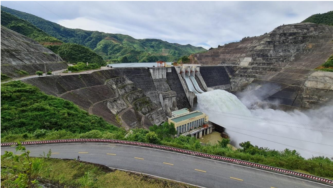
Hình 1- 2 – Đập dâng nhà máy thủy điện Bản Chát (nguồn Internet)
