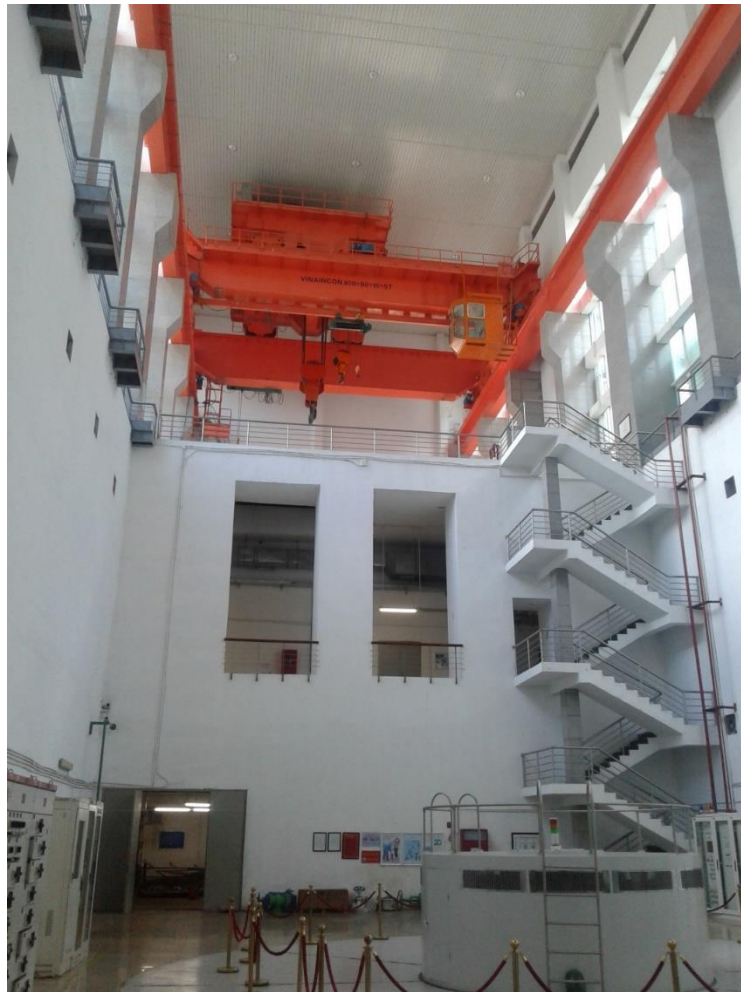
Hình 1- 5 – Nhà máy thủy điện
