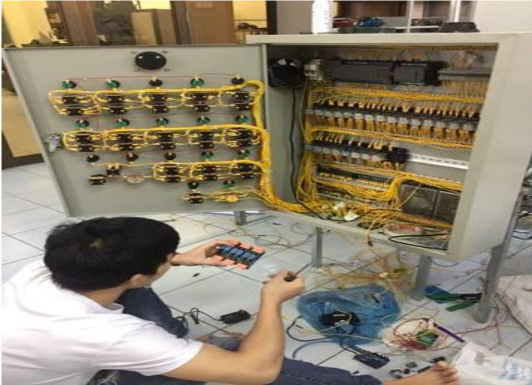
Hình 3.10 Chi tiết lắp đặt tủ điện
