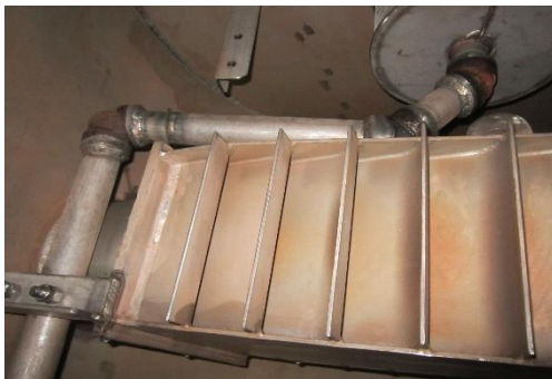
Hình 7: Cấu tạo của bộ phận đầu vào kiểu cánh gạt.
