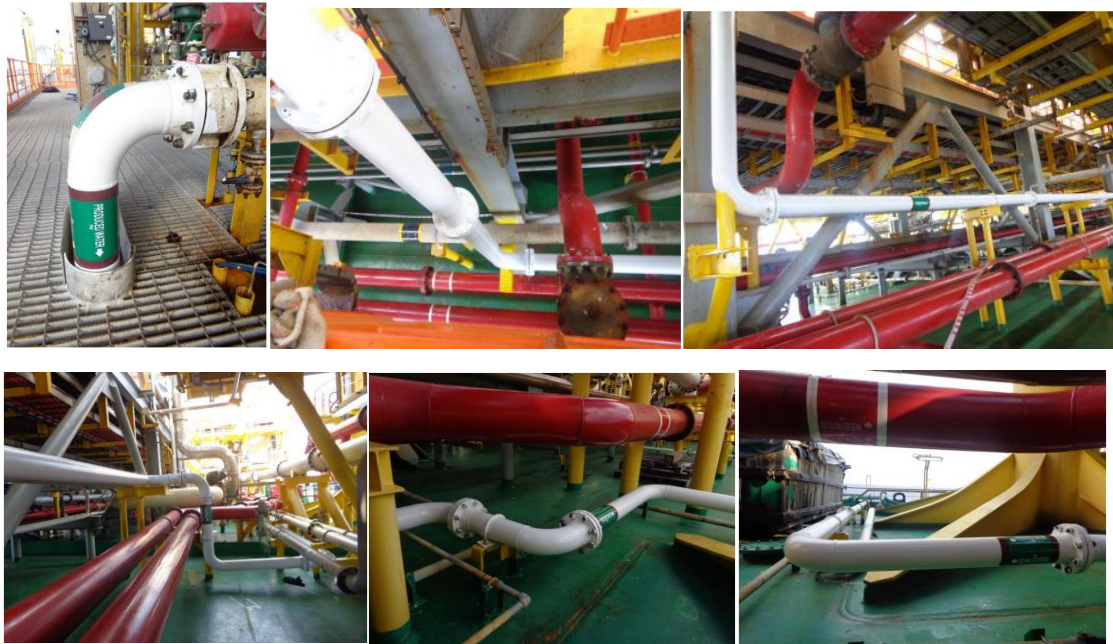
Hình 10: Hình ảnh tuyến ống nước khai thác sau khi thay thế lắp mới
