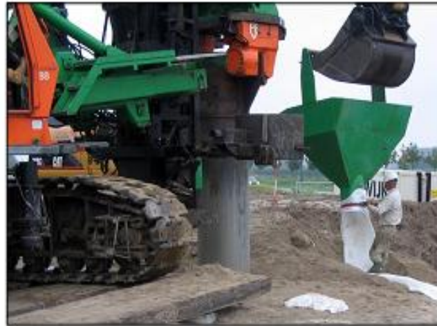
2. a screw thread in geotextile, stone pour
