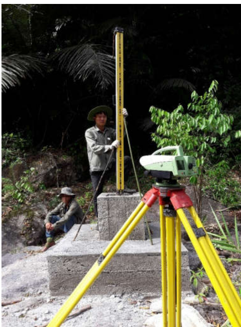
Hình 1.7 Đo lưới thủy chuẩn thủy công thủy điện Alin B2 [10]
