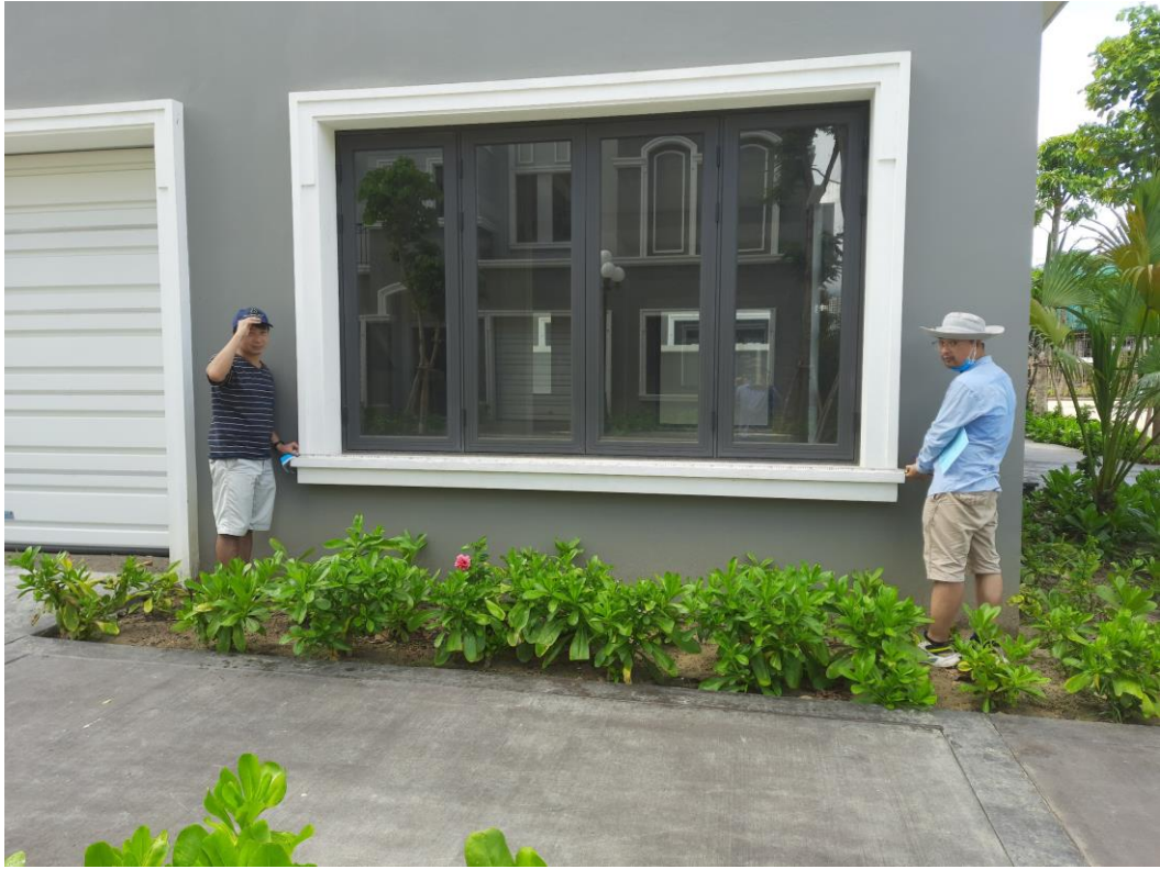
Hình 25. Đo kiểm tra chiều rộng của cửa sổ bằng thước thép
