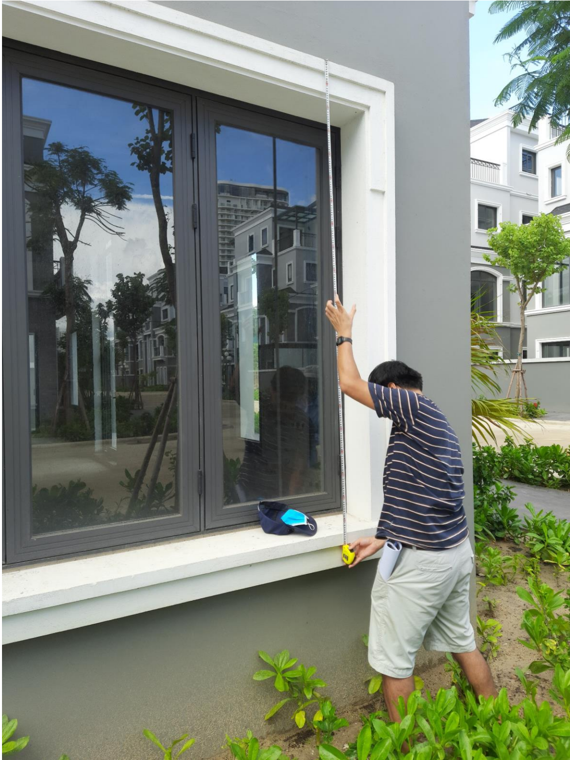
Hình 2.7 Đo kiểm tra chiều cao của cửa sổ bằng thước thép
