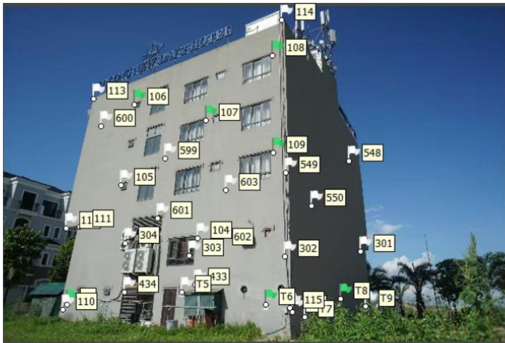
Hình 18. Các điểm đặc trưng trên bề mặt phía sau toàn nhà được xác định vị trí không gian bằng toàn đạc điện tử ở chế độ đo không gương
