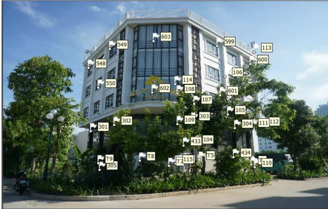
Hình 17. Các điểm đặc trưng trên bề mặt phía trước tòa nhà được xác định vị trí không gian bằng toàn đạc điện tử ở chế độ đo không gương
