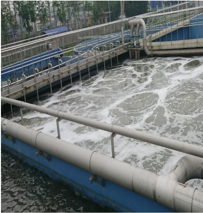
Hình 1.6. Bể aero tank xử lý nước thải sinh hoạt đô thị
