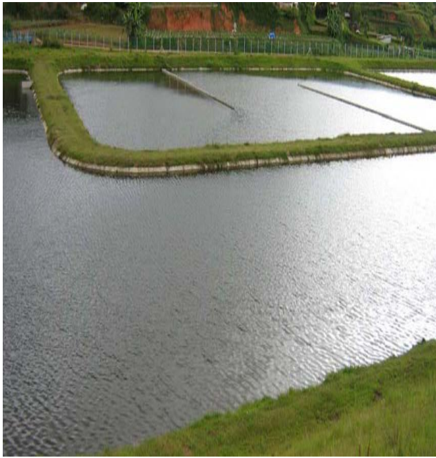
Hình 1.3. Hồ sinh học xử lý nước thải
