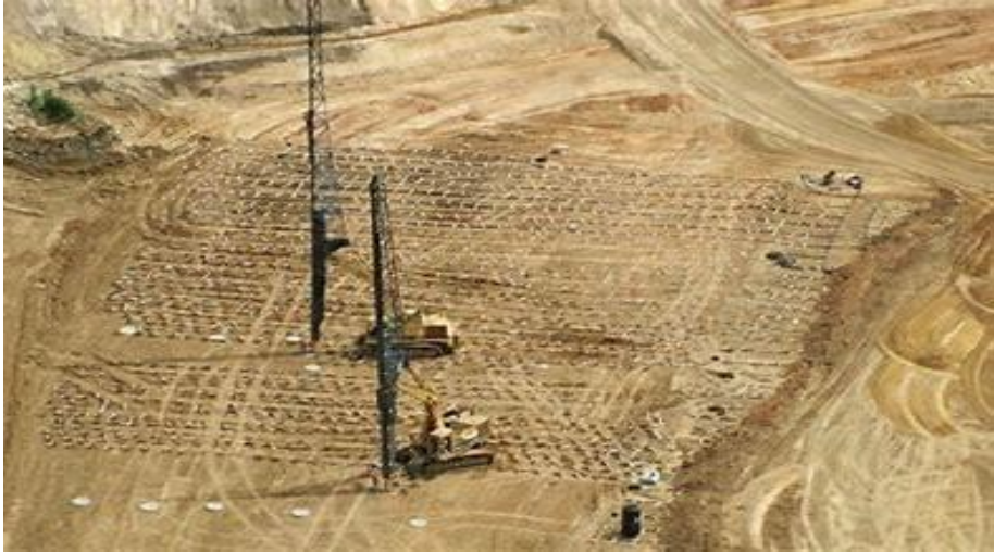
Hình 4.6. Thiết bị thi công bắc thăm
