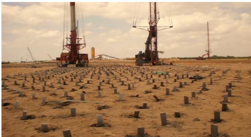
Hình 4.7. Thi công bắc thắm tại công trường
