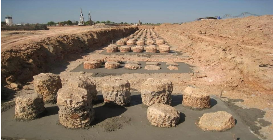
Hình 4.14. Cọc đất - xi măng sau khi thi công
