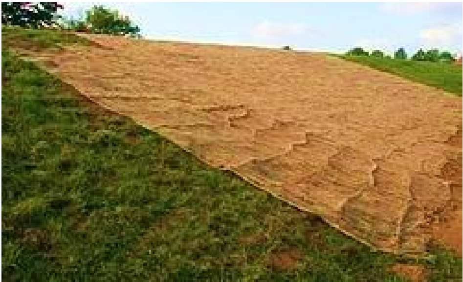
Hình 4.3. Sử dụng vải địa kỹ thuật làm tấm ngăn cách
