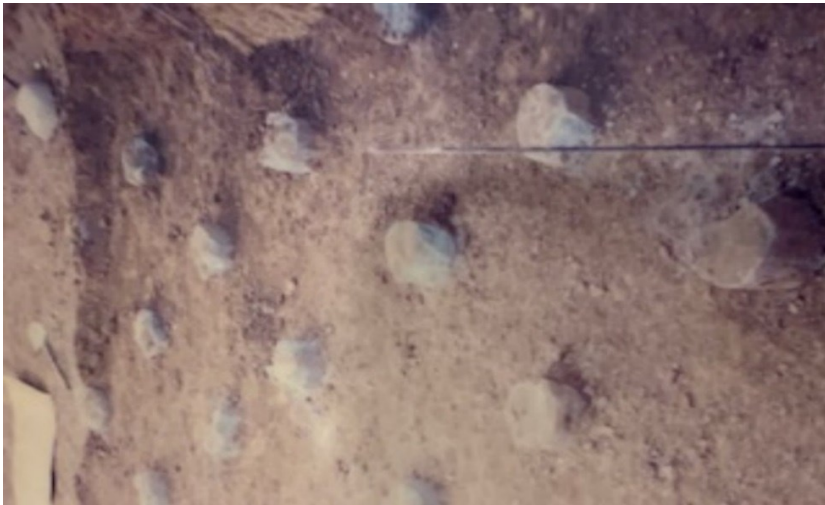
Hình 5.27. Hiện trường cọc cát - xi măng - vôi thi công bằng UGB-50M
