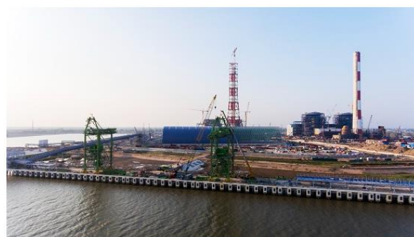
Ảnh 2. Nhà máy nhiệt điện Thái Bình 1
