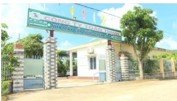
Ảnh 1. Nhà máy cấp nước
