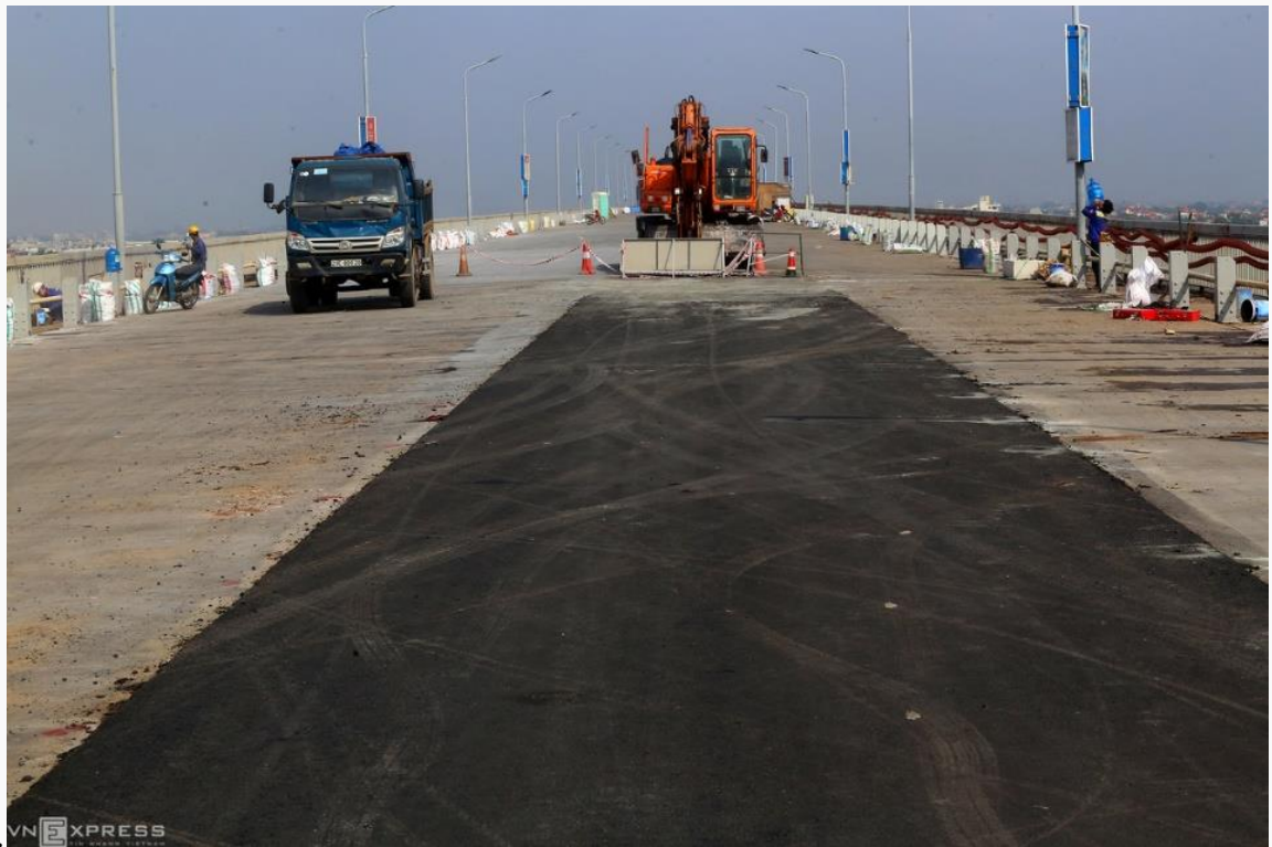
Hình 28. Thảm lớp bê-tông nhựa polyme phía trên
