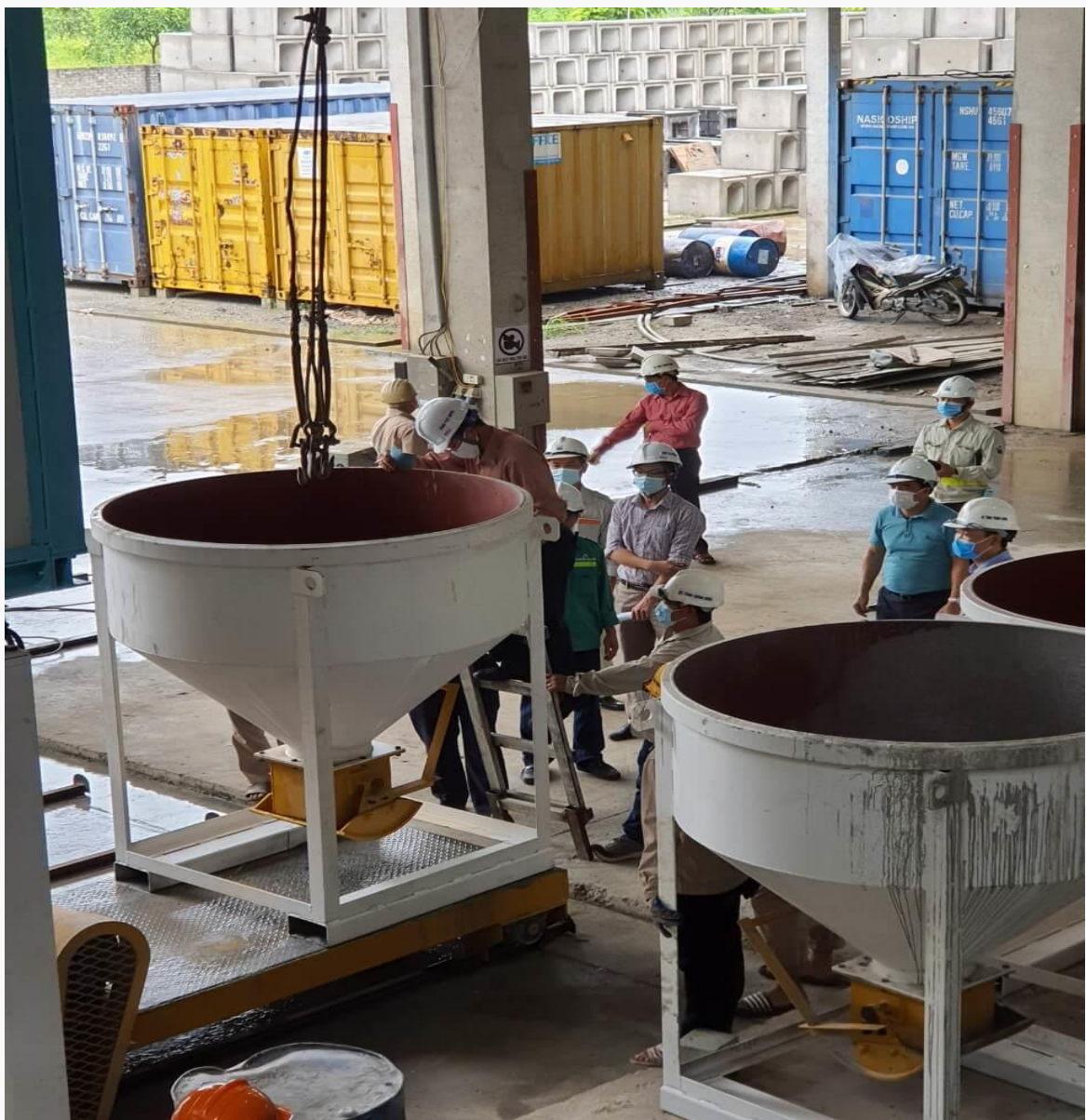
Hình 18. Thiết bị, quy trình thi công lớp UHPC để sửa chữa mặt cầu Thăng long
