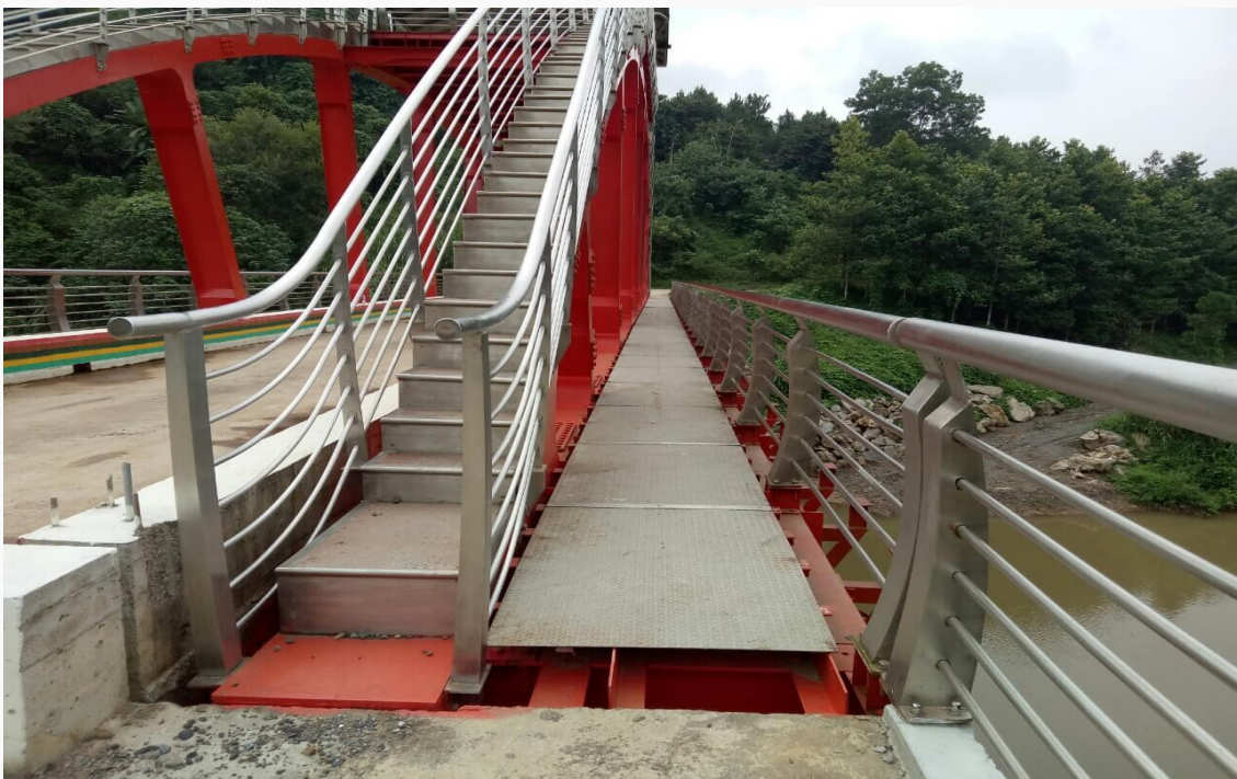
Hình 17. Cầu dân sinh đúc sẵn làm từ BTTNSC
