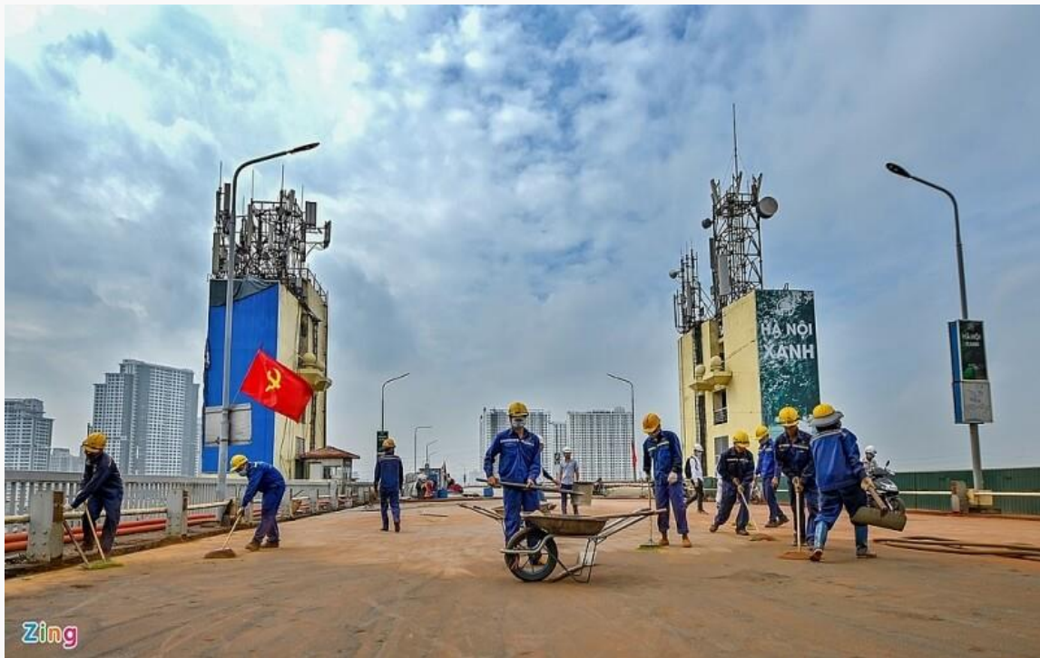
Hình 23. Làm sạch bản mặt thép của cầu
