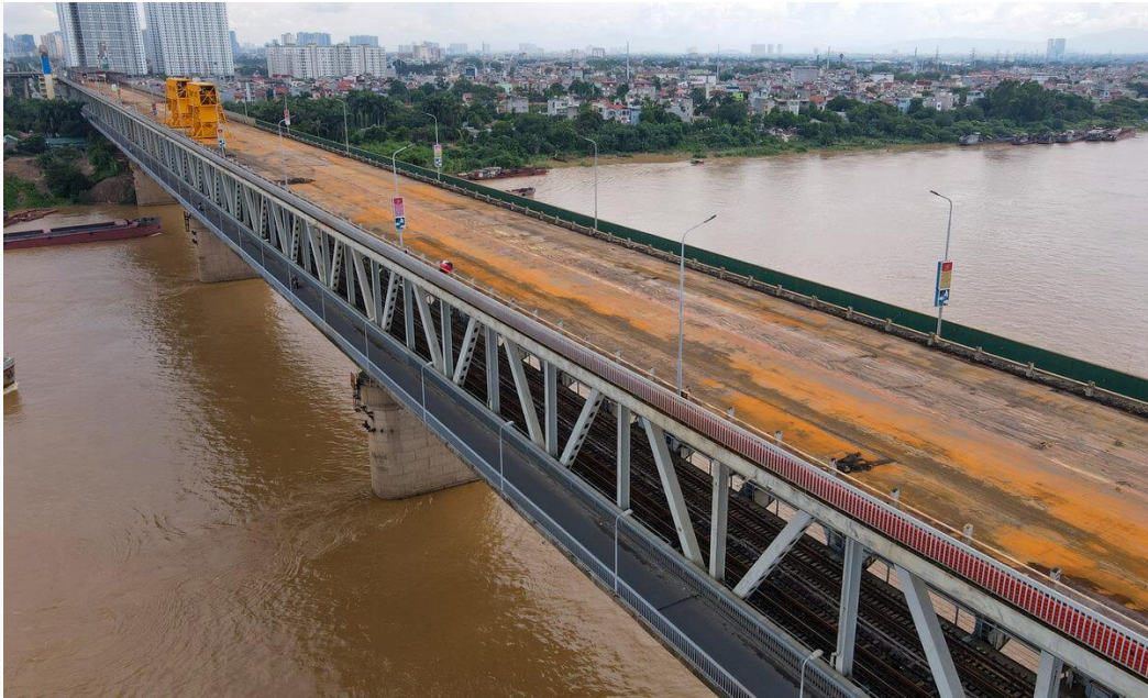
Hình 22. Cạo lớp nhựa bê tông mặt cầu Thăng Long
