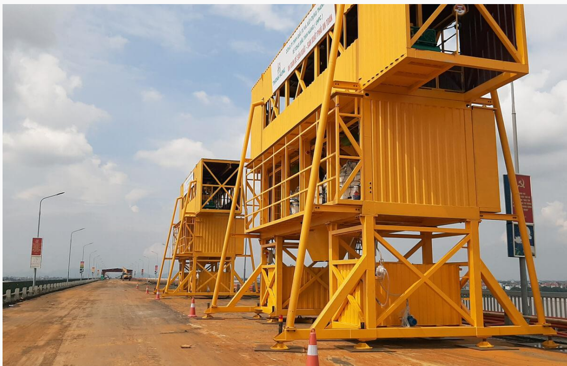
Hình 25. Trạm trộn bê tông uhpc tại công trường
