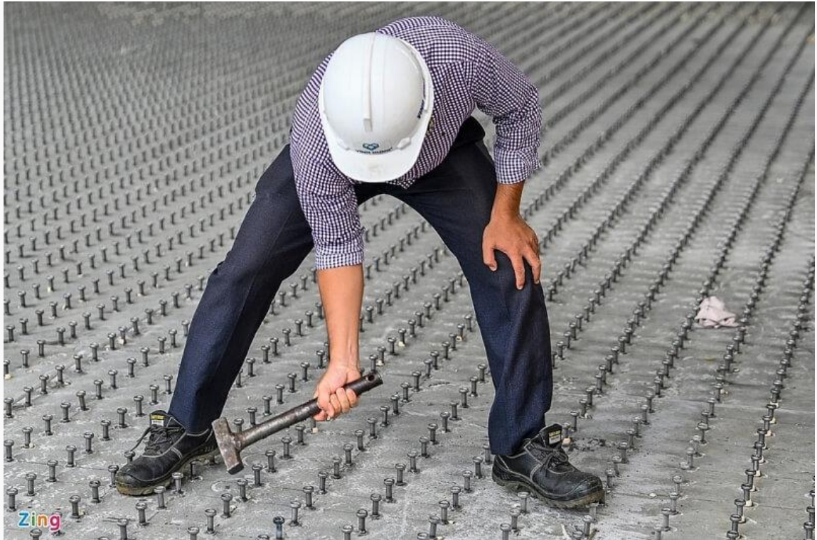
Hình 24. Chôn bu lông neo và lưới thép trên bản thép mặt cầu đã làm sạch gỉ
