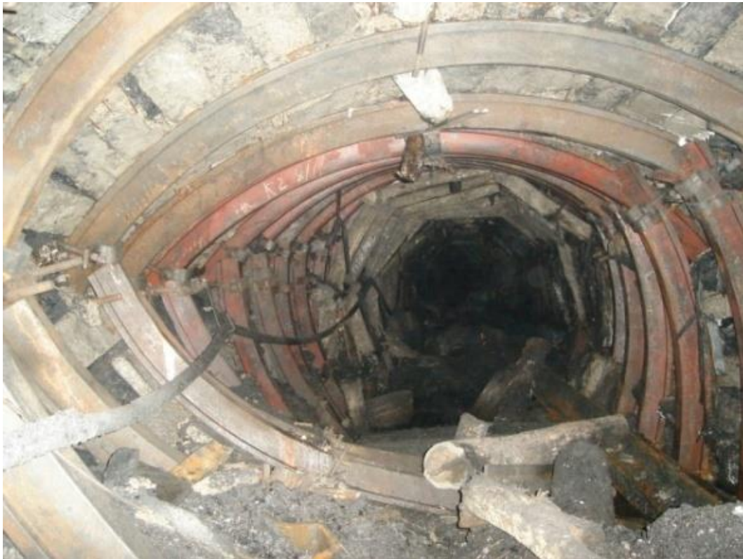
Hình 1: Hiện tượng phá huỷ khối đá xung quanh đường lò tại mỏ than Đồng Rì
