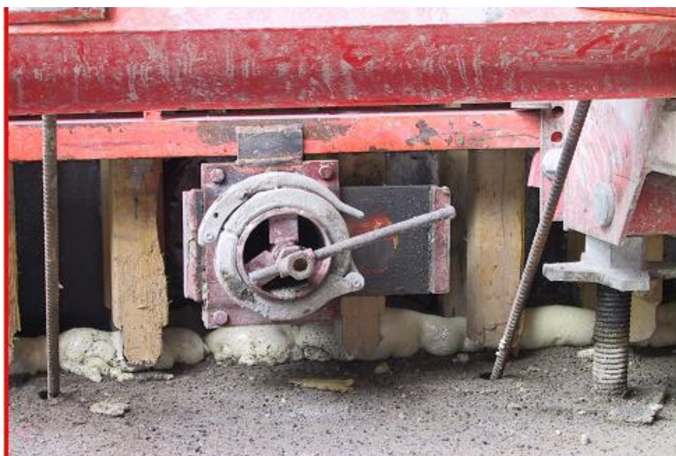
Hình 3.3 Van cấp bê tông cho giải pháp bơm từ chân ván khuôn
