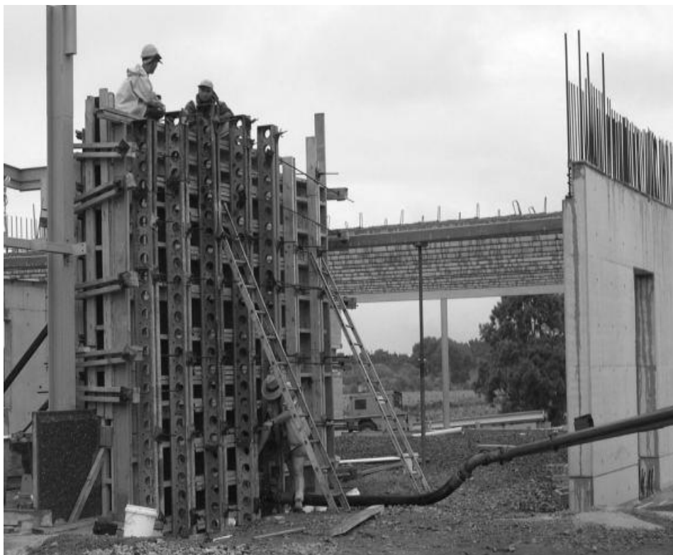
Hình 3.2 Bơm bê tông tự đầm từ dưới chân vách lên
