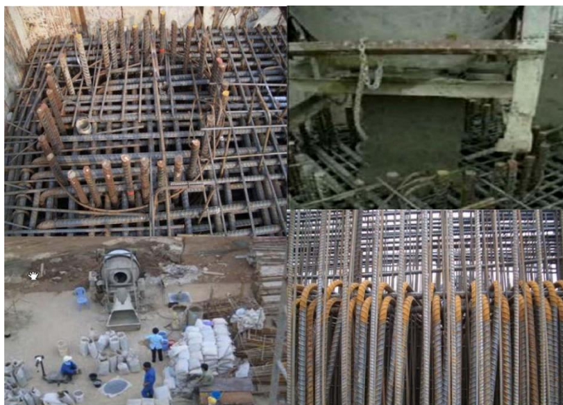
Hình 1.4 Thi công nút liên kết dầm cột tòa nhà T34 ở Trung Hòa- Nhân Chính -Hà Nội
