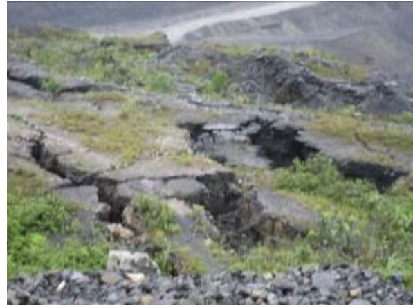
Hình 3.5: Sụt lún và nứt bề mặt khu vực trung tâm từ +200÷260m
