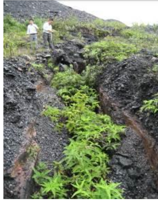
Hình 3.4: Khe nứt trượt phát triển tại khu vực trung tâm trên cao trình +240÷260m
