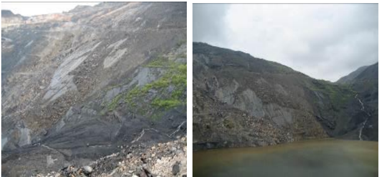
Hình 3.7: Mặt trượt thứ cấp theo tiếp xúc lớp khu vực chân bờ Trụ Nam
