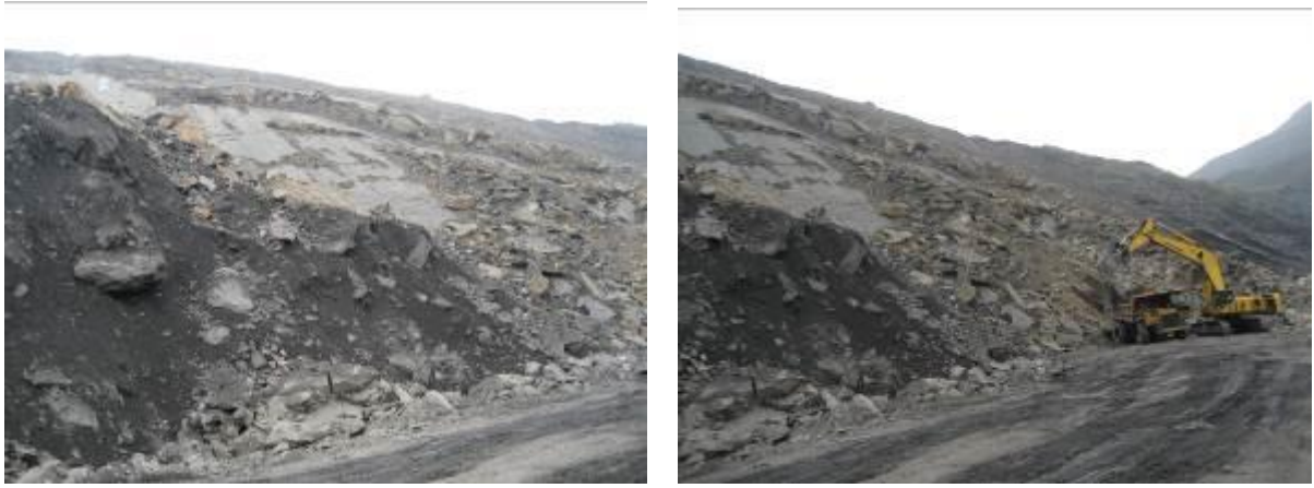
Hình 3.6: Xúc bốc xử lý trượt lở từ mức +72 ÷ +150m
