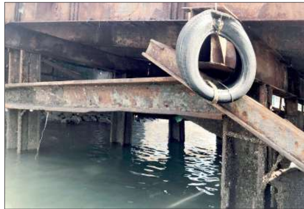
Рис. 2. Коррозия и повреждение стальных конструкций пирсов в заливе Халонг (Вьетнам) Fig. 2. Corrosion and damage to steel structures of piers in Halong Bay (Vietnam)
