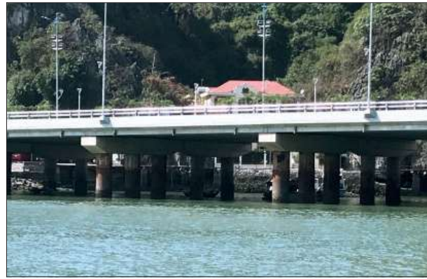
Рис. 1. Строительные работы в заливе Халонг (Вьетнам) Fig. 1. Construction work in Halong Bay (Vietnam)
