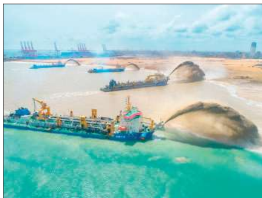
Рис. 7. Работы по углублению морского дна и сбор обломков мертвых коралловых рифов, раковин моллюсков и морской гальки Fig. 7. Seabed dredging and collection of dead coral reef debris, shellfish and sea pebbles
