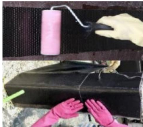
b) phương pháp dán tấm bê tông
