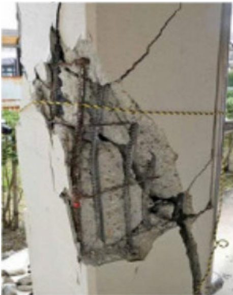
b) Bê tông bị phá hoại
