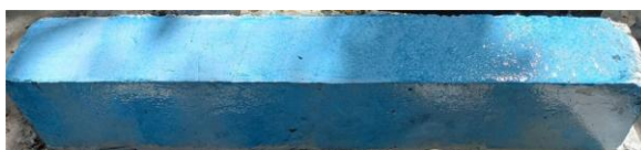
Hình 14. Lăn phủ lớp keo epoxy TCK 510R lên bề mặt các dầm
