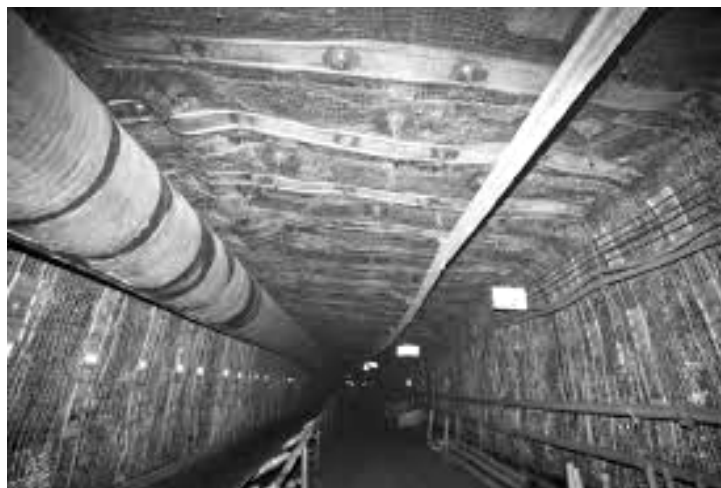
Hình 5. Chống neo cáp tại các đường lò than
