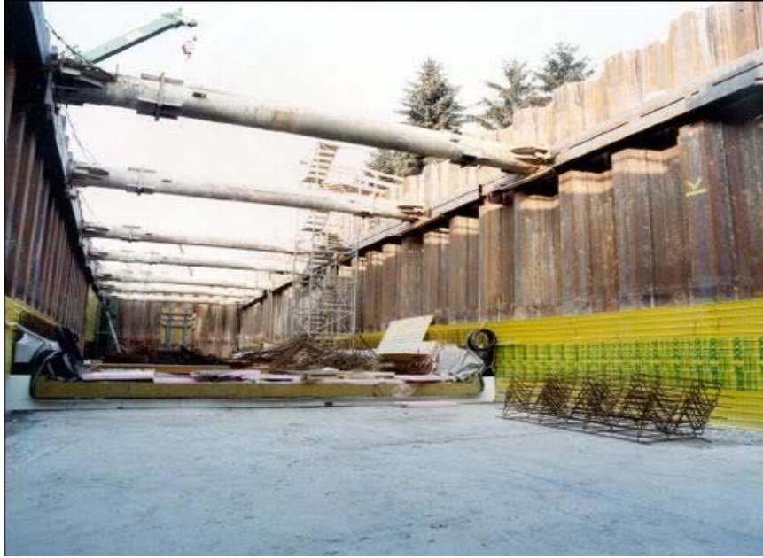
Hình 7. Ứng dụng cừ ván thép trong xây dựng đường hầm giao thông [4]
