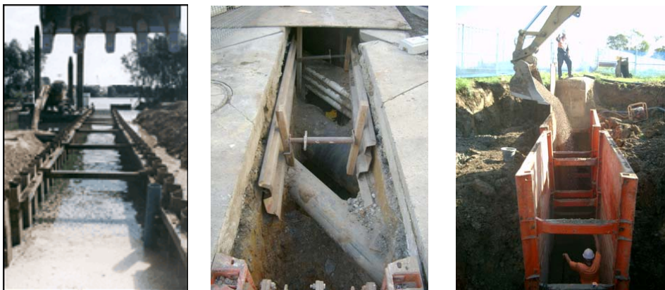
Hình 2. Phương pháp xây dựng đường ống bằng phương pháp lộ thiên [2]
