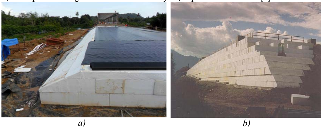
Hình 4.3. Một số hình ảnh sử dụng công nghệ geofom để xử lý nền đường đầu cầu đắp trên đất yếu
