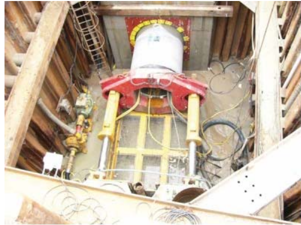
Hình 4. Giếng khai đào đường hầm tiết diện nhỏ, đường Czerniakowskiej Vácava – Balan [5]
