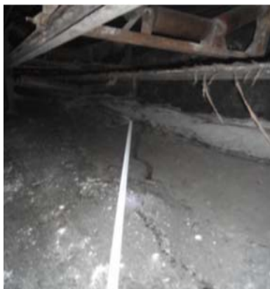
Hình 5. Lò vận tải 7008 vỉa 70
