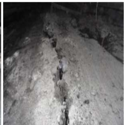
Hình 6. Lò thông gió 7009 vỉa 70
