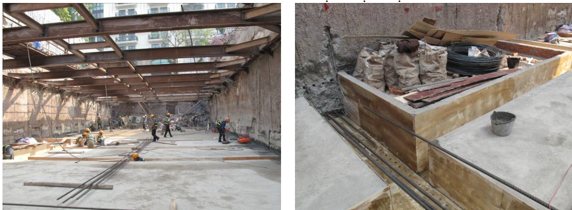
Hình 2.13. Hình ảnh thực tế công trình
