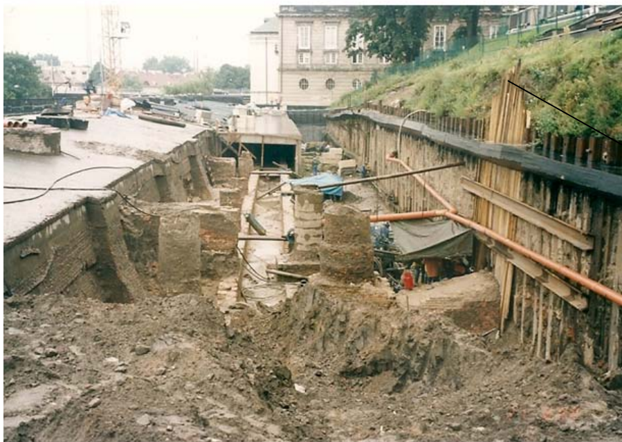
Hình 10. Ứng dụng cừ ván thép 2 tầng neo tại công trình khu văn hóa thuộc cung điện hoàng gia Vácava – Balan [2]
