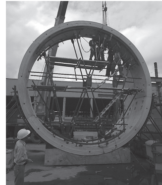
Hình 3.1: Vỏ hầm tuyến metro số 1 TP. Hồ Chí Minh Bến Thành - Suối Tiên
