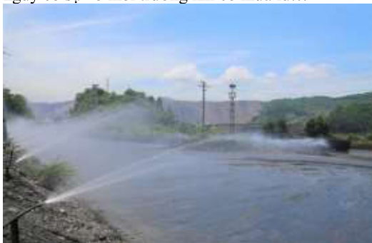
Hình 1. Công ty CP than Hà Tu lắp đặt hệ thống phun sương bảo vệ môi trường tại các tuyến đường, khu vực kho than. (Tập đoàn công nghiệp Than - Khoáng sản Việt nam, 2023)
