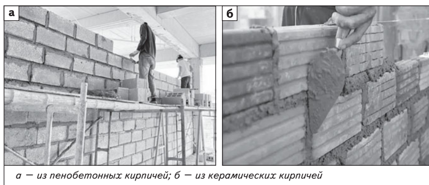
Рис. 1. Возведение кирпичных стен жилых зданий
