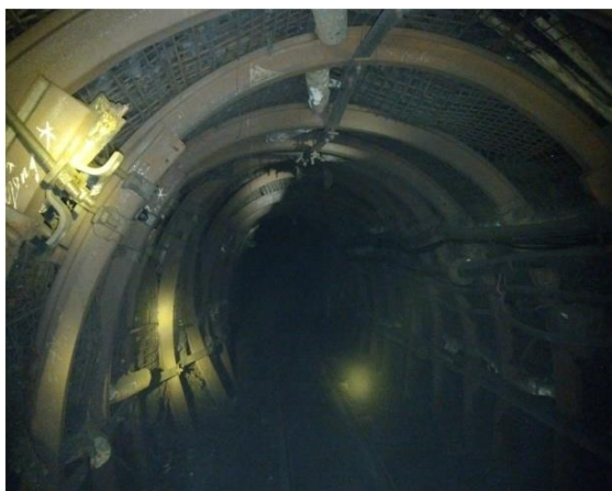
Hình 1. Hiện tượng đường lò bị nén ép mạnh tại đoạn lò không chống neo bị nén thi công từ năm 2019 thuộc lò DVTG 14.4-2, khảo sát ngày 12/05/2021
