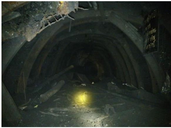
a) Đường thượng Vận tải 14.5 khu Đông Nam, Khe Chàm III bị biến dạng
