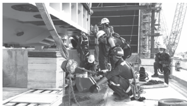
Kỹ sư và các công nhân có trình độ cao và lành nghề của LILAMA 10 đang căn chỉnh để đưa máy phát vào vị trí bộ móng.
