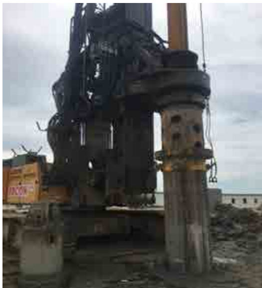
Hình 3. Hình ảnh khoan full casing với hệ thống adapter.
