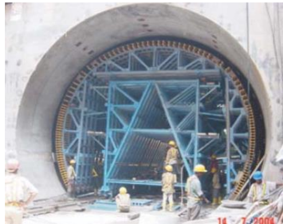
b) Tro bay được sử dụng làm bê tông liên khối tại dự án hầm metro Delhi Metro Rail Corporation, Ấn Độ [3]
