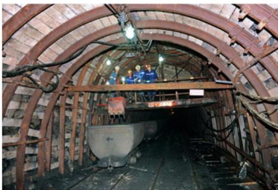
Hình 2. Hình ảnh tấm chèn bê tông cốt thép sử dụng thực tế (a); mô hình tính toán tấm chèn (b) và sơ đồ tải trọng trong đất đá tác dụng lên tấm chèn (c)
