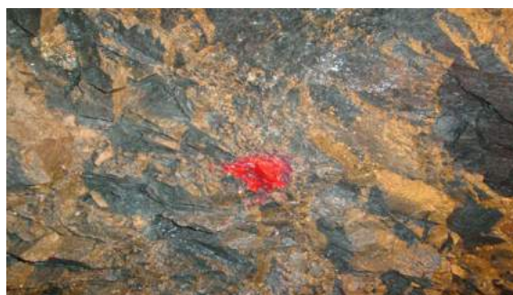
Hình 8. Hình ảnh điểm vẽ gương hầm/lò trên thực tế (Tổng Công ty Sông Đà, 2001).
