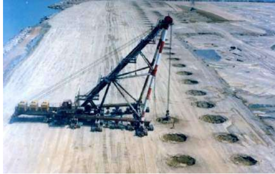
Hình 1. Phương pháp đầm chấn động Menards tải trọng 200 tấn (Adalier và Sharp, 2004).
