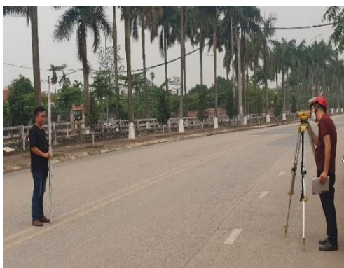
Hình 2. Dẫn thủy chuẩn tới các điểm kiểm tra
