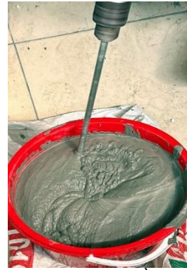
(b) Trộn hỗn hợp bê tông bột bằng thiết bị thủ công
