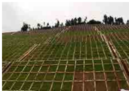
(b) Gia cố sâu bằng đỉnh đất linh hoạt kết hợp khung BTCT và trồng cỏ
