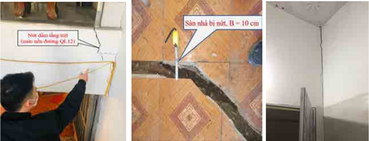
(a) tầng bán hầm CT5 (b) sàn tầng hầm CT5 (c) vết nứt trên tường
