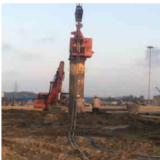
Hình 4. Rút casing bằng búa rung sau khi đã hoàn thiện đổ bê tông lỗ khoan.
