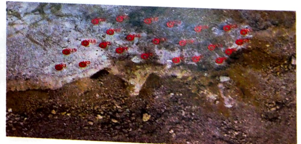
Hình 9. Vị trí các lỗ khoan nổ mìn được thiết kế và định vị ngoài bãi mìn theo GPS RTK
