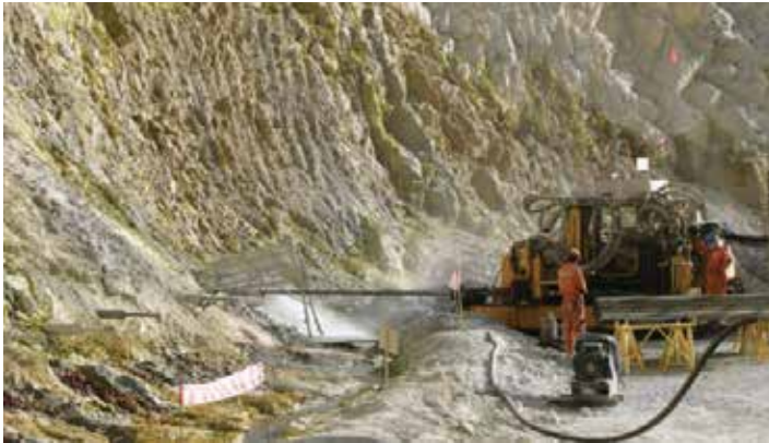
a, Khoan tháo nước tại chân tầng [9]
