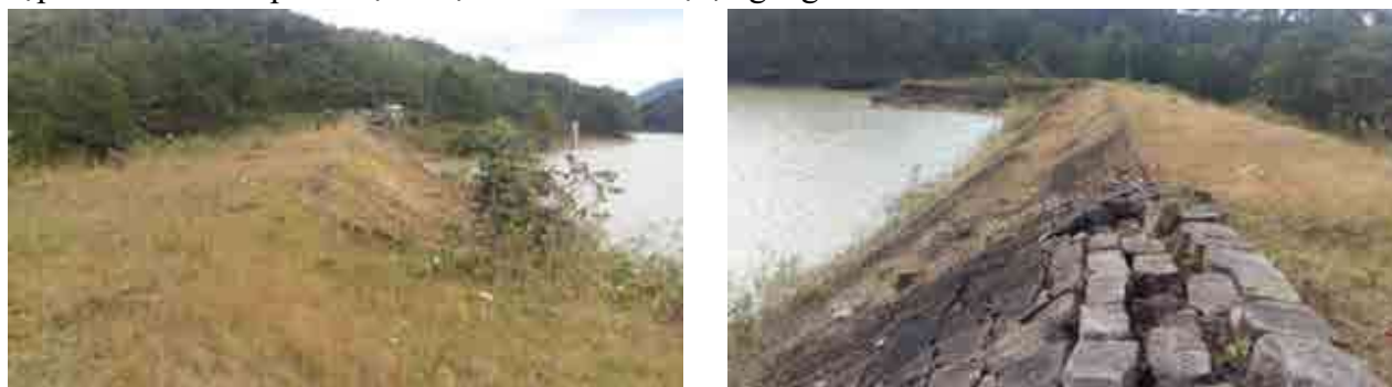
Hình 3. Hiện trạng gia cố đỉnh đập.
