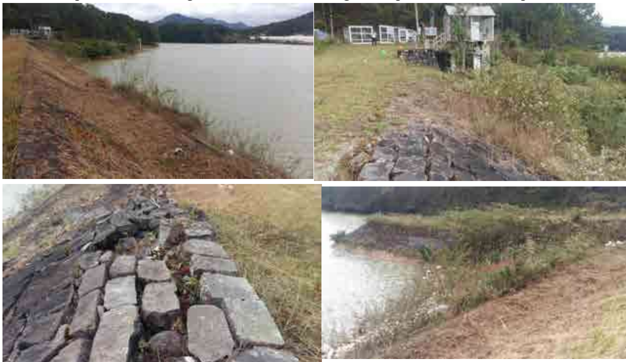
Hình 2. Bê tông gia cố mái thượng lưu.
