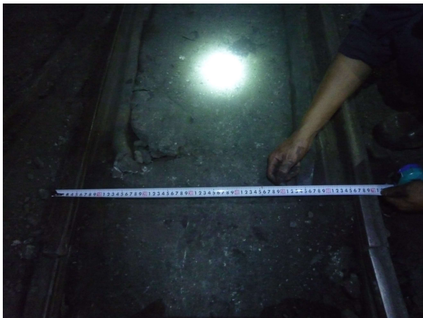
Hình 4. Đo kiểm tra khoảng cách giữa 2 thanh ray bằng thước thép.
