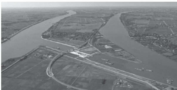
Toàn cảnh Dự án kênh Nghĩa Hưng (Cụm công trình kênh đào nối sông Đáy – Ninh Cơ) thuộc Dự án Phát triển giao thông vận tải khu vực đồng bằng Bắc Bộ (Dự án WB6), nằm trên địa bàn huyện Nghĩa Hưng, tỉnh Nam Định.
