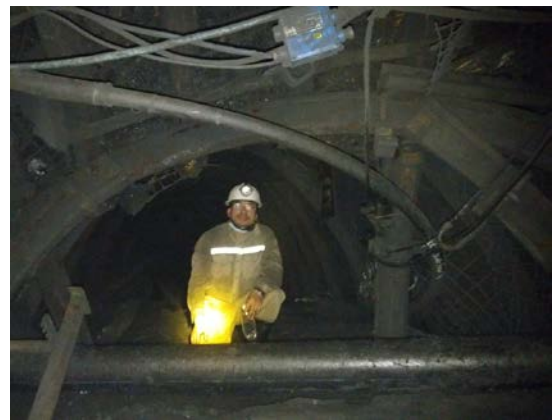
b) Đường thượng Vận tải 14.5 khu Đông Nam, Khe Chàm III bị lún nóc
