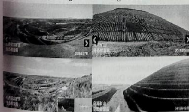
Hình 3: Hình ảnh thi công phủ xanh mái dốc tại công trình ở Trung Quốc
