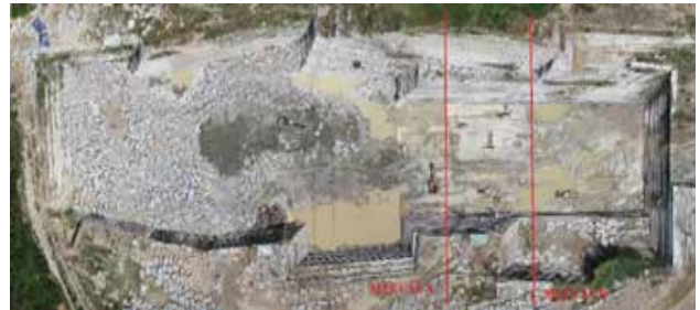
H. 3. Ảnh trực giao mỏ đá ốp lát Núi Ngang và vị trí các mặt cắt
