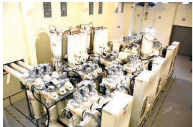
Hệ thống thiết bị đóng cắt hợp bộ (GIS) được điều khiển từ xa
