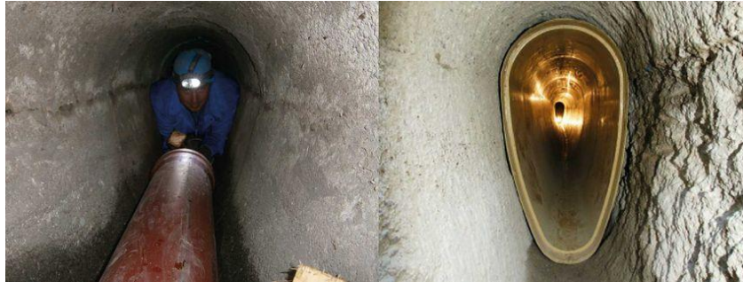
Hình 4. Sửa chữa từng phần đường ống [6]
