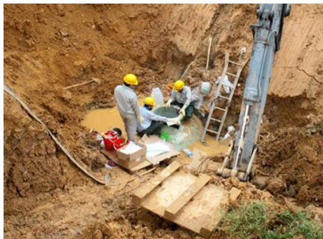
Hình 1 Đường ống bị vỡ trong quá trình khai thác tại Hà Nội [1]
