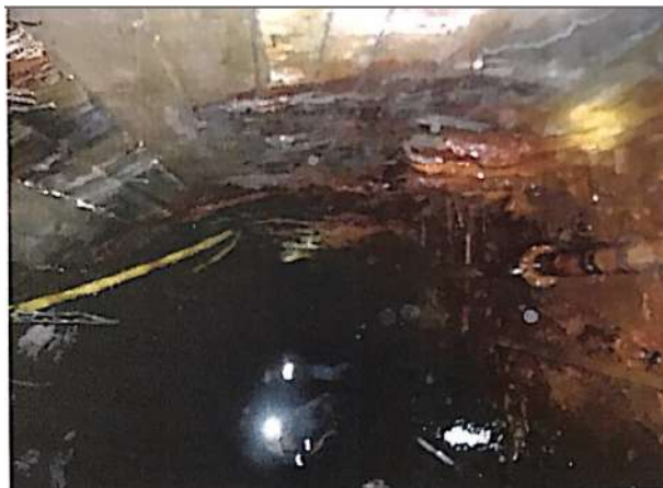
Hình 5. Vỏ chống bê tông lưu vì bị phong hóa
